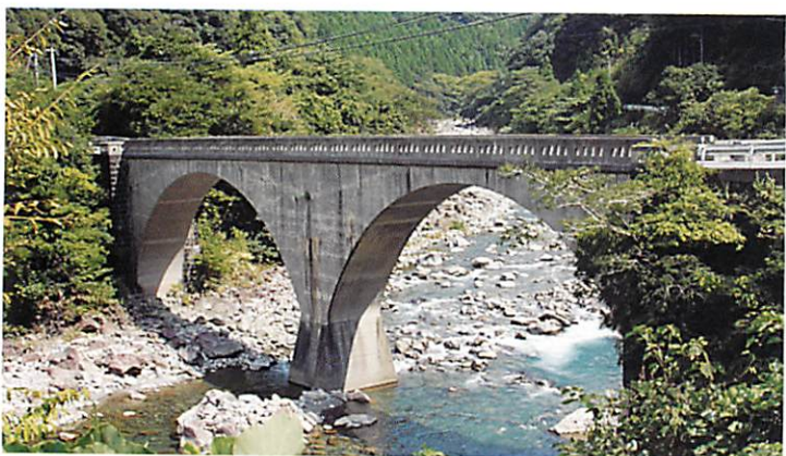
高知県北川村二股橋
